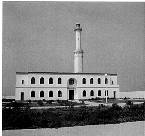
写真 ララシュ漁業技術向上センター（建物は学生寮）
