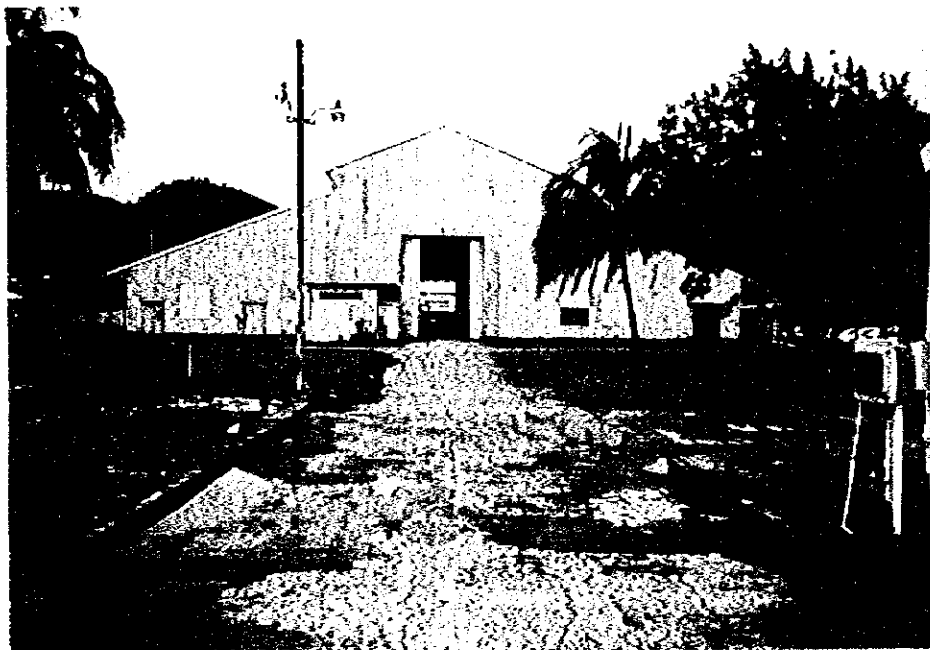
写真2 CFTDI 実習訓練棟
