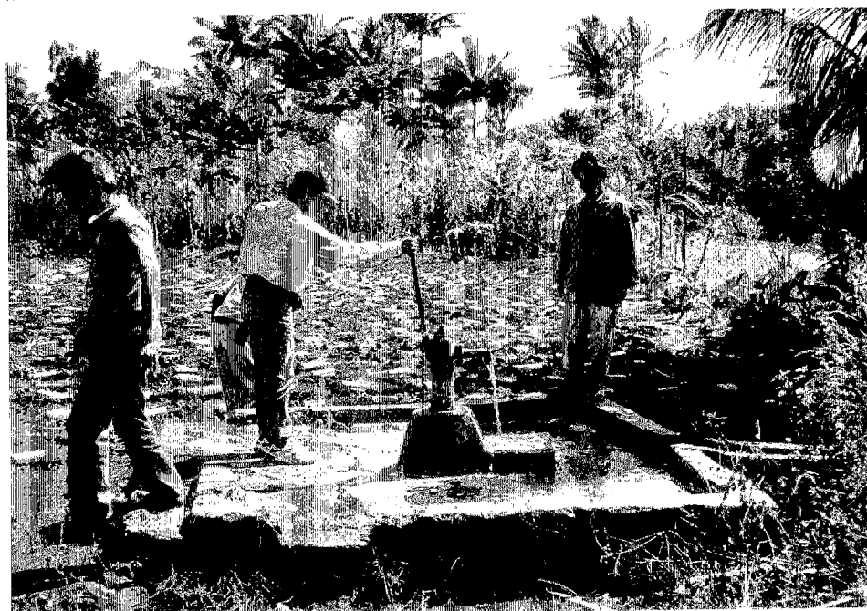
NTT 西ティモール TTS県 Tetaf村に設置されたハンドポ ンプ。水量水質良好
