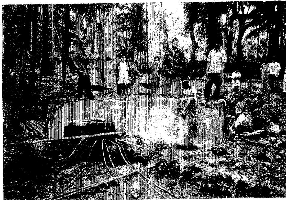
NTT 西ティモール クパン県 Braen村の湧水地タンクから引 かれていたホース
