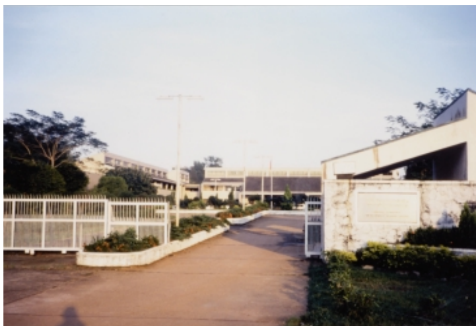
中央林業開発訓練センター (CFDTC) 外観
