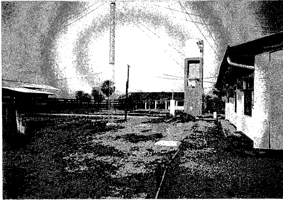
プロジェクト施設
