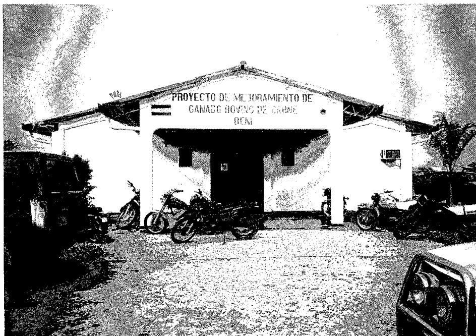
プロジェクト・サブサイト事務所施設
