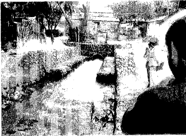
Rafey処理場のオーバーフローゲートから越流して ジャケ・デル・ノルテ川に放流される未処理の下水
