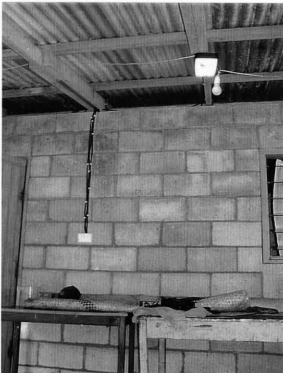
天井板がなく、トタン屋根のすぐ裏側に取り付けられた蛍光灯 (18W)
