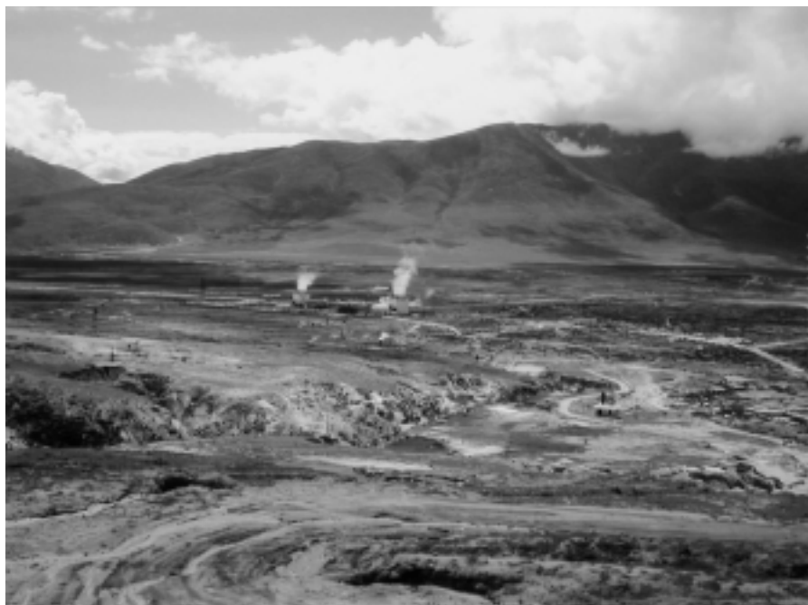
北部地熱フィールドからみた 羊八井地熱地帯(中央が第2発電所)
