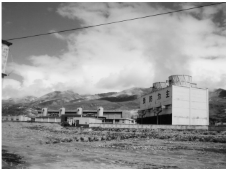
羊八井地熱発電所第2発電所全景
