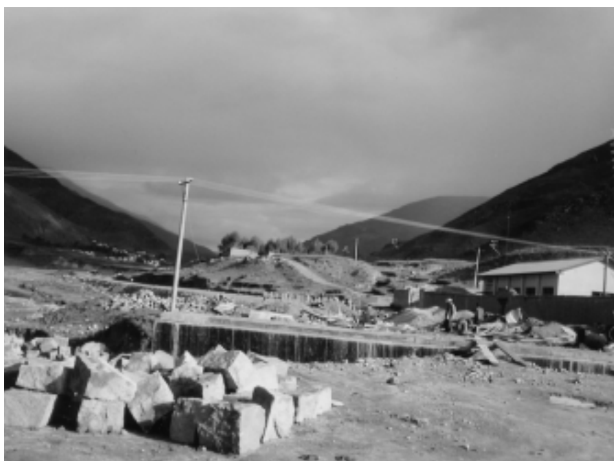
ラサ羊八井までの道路状況 全面改修中（所要3.5時間） （中央部はカルバート工事中）
