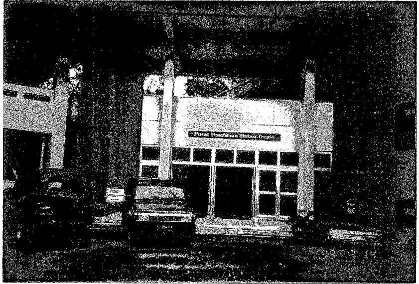
▶ インドネシア熱帯降雨林研究 センター (PUSREHUT) 正面
