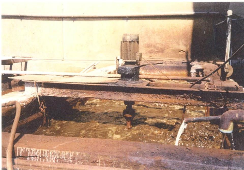
写真 NSP-3 酸洗廃水の中和装置
