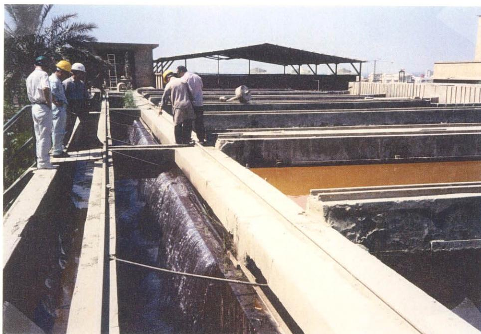
写真 NSP-4 循環冷却水のオイルセパレーター
