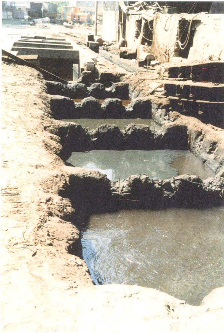
写真 DSM-1 排水溝に設けられたオイルトラップ
