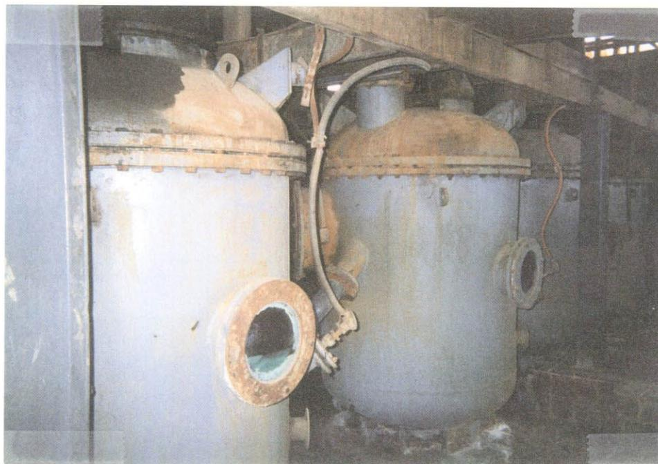
写真 EIS-8 廃酸回収設備
