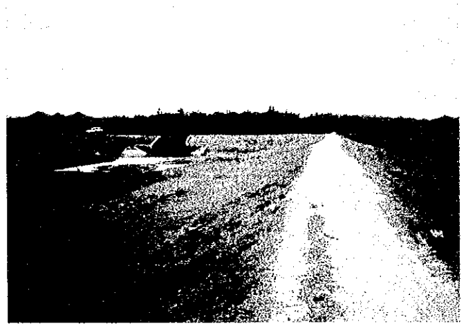
Nam Nam 堤防 (堤防越流堤、排水ゲート建設予定地および改修予定排水ゲート)
