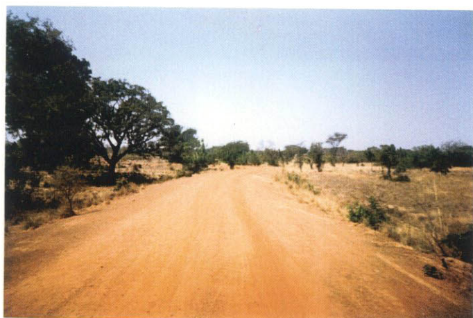
S-27、S-28、M-20を連絡する支線道路
