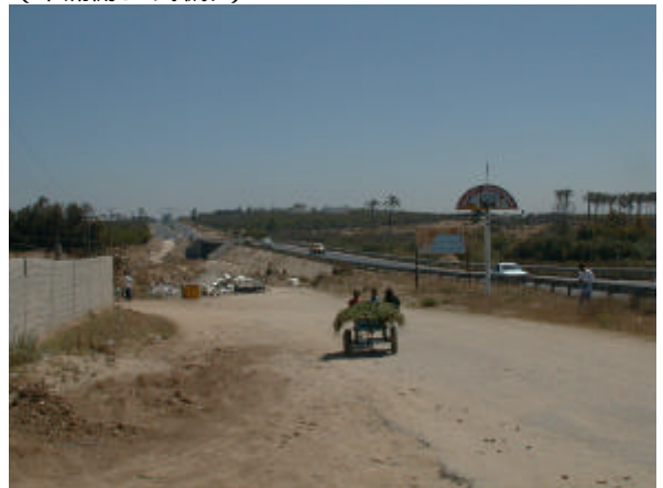
ワディ・ガザ橋南側より望む (既設橋左側が新設橋梁建設予定地)
