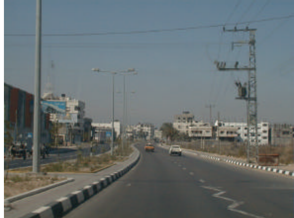
新4号(サラ・エル・ディン道路)の整備の状況 (エレッツ~ワディ・ガザ橋間は世銀等により整備)
