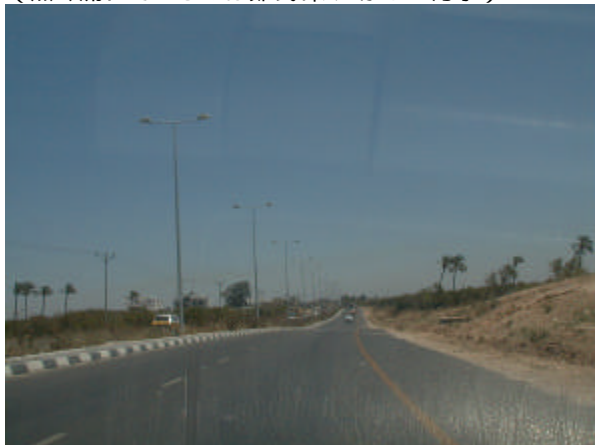
4号線南側区間の状況(4車線区間) (旧4号線交差点からは歩道はなく、広路肩となっている)
