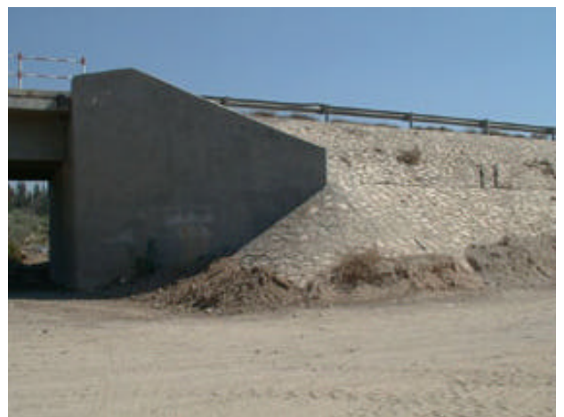
写真 - 2.4.8 法面防護工
