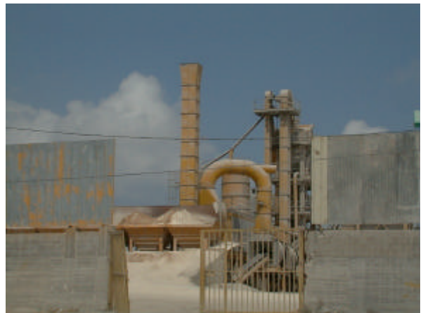
アスファルトコンクリートプラント
