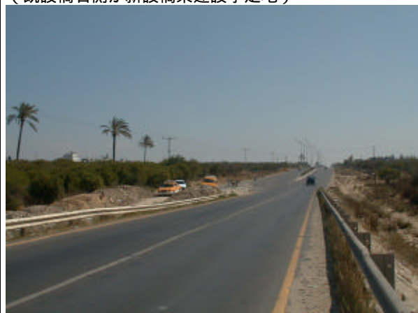
ワディ・ガザ橋より4号線北側を望む
