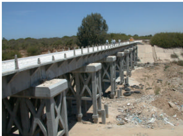
ワディ・ガザ橋下流部にある元鉄道橋 (現在道路橋として使用されている)
