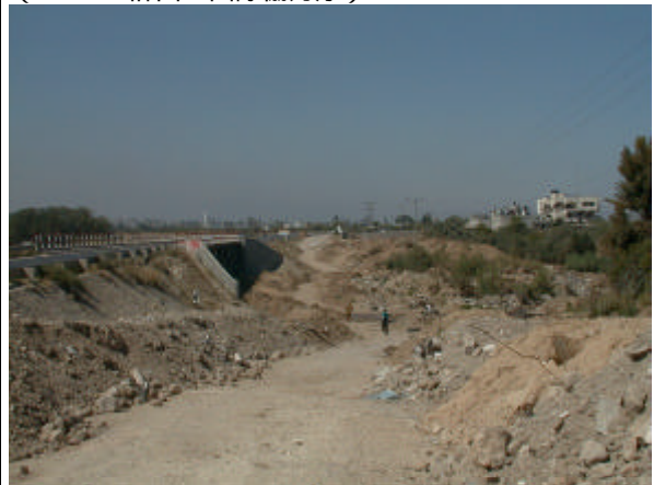
ワディ・ガザ橋北側より望む (既設橋右側が新設橋梁建設予定地)
