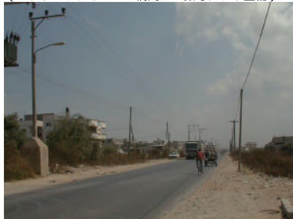
旧4号線の状況(2車線区間) (沿道には工場が並ぶ)
