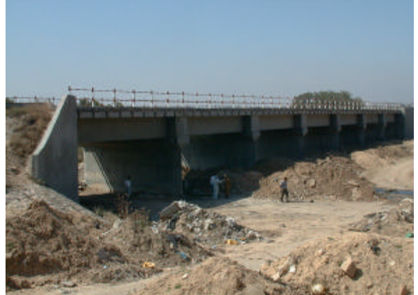
ワディ・ガザ橋 (下流側より撮影)
