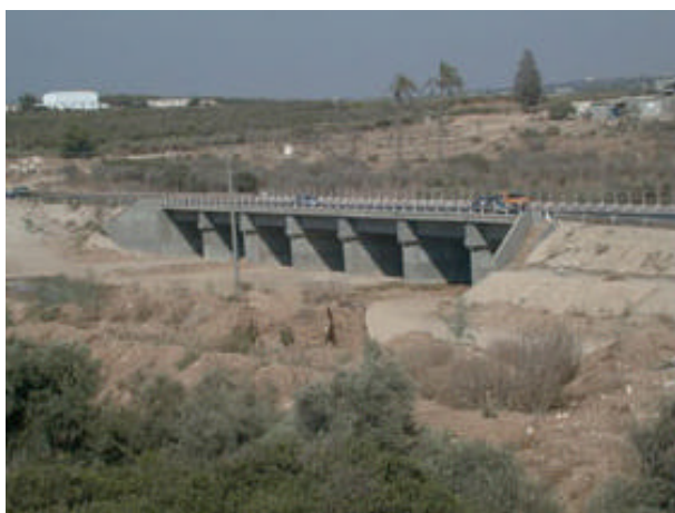
写真 - 2.4.1 既設橋梁全景
