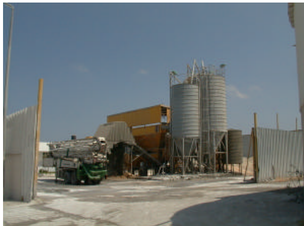
コンクリートプラント
