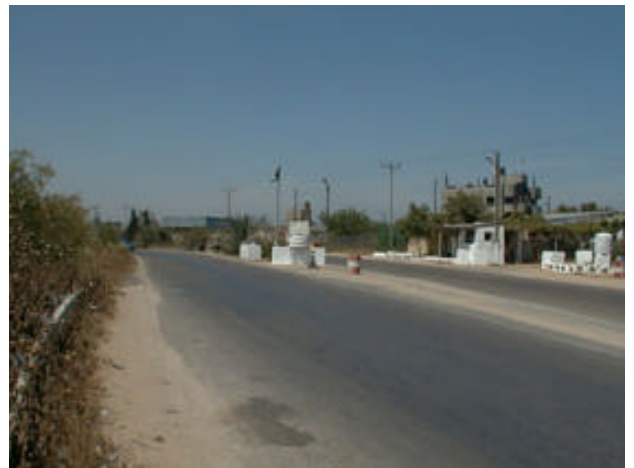
写真 - 2.4.6 ハーンユニス側道路
