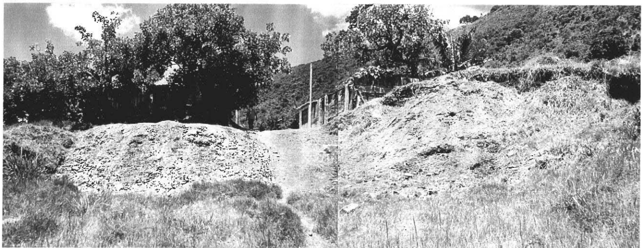
Vista de la barranca después del proyecto piloto
