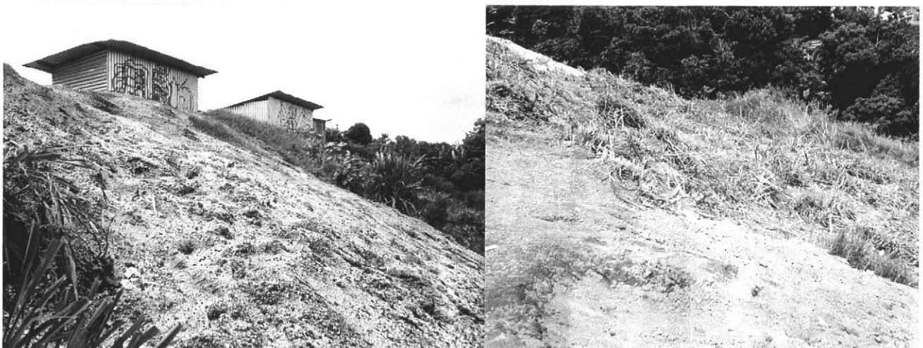
Vista de la barranca después del proyecto piloto
