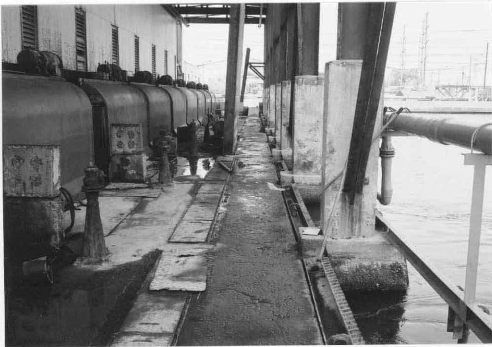
冷却水の取水口
