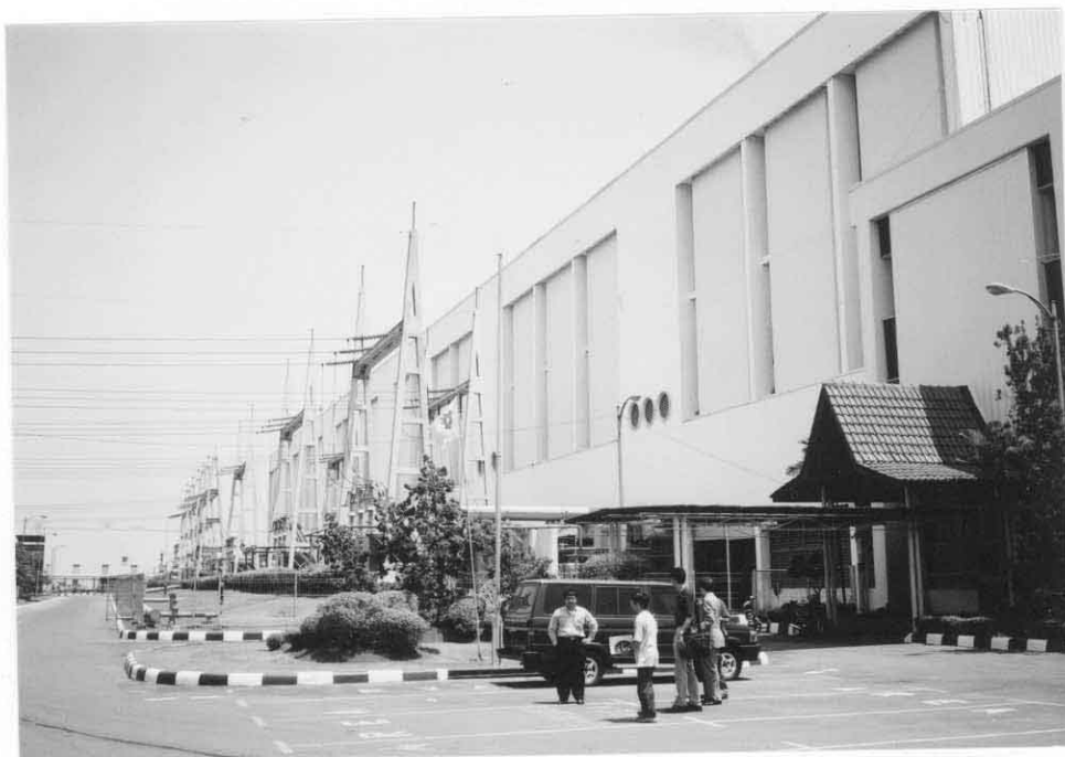
Muara Karang 発電所全景
