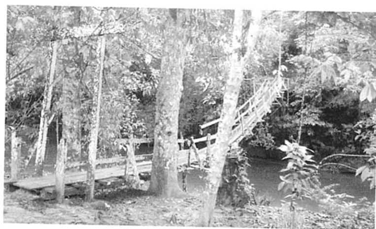
Pain 村から Semban 村への出口の吊橋。硬い南洋材製であるが維持管理は良くない。
