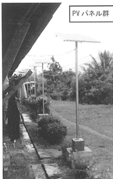
Longhouseペランダ内部より
