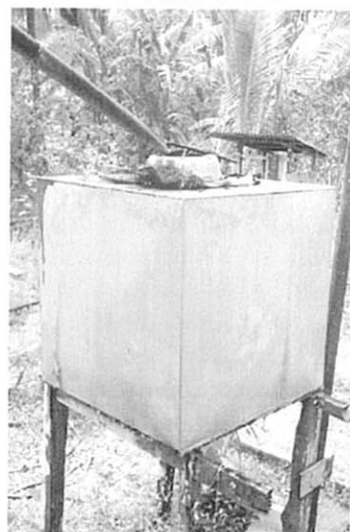
屋根からの雨水タンク
