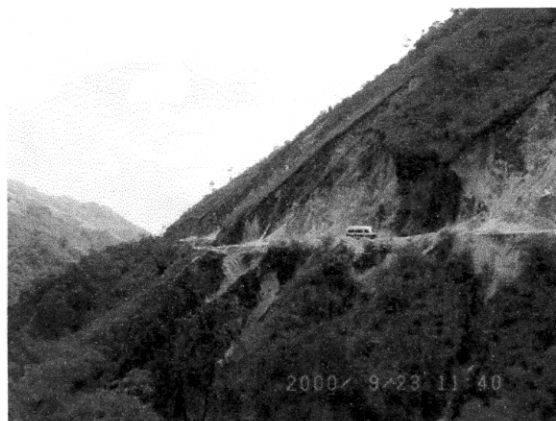
サルウイーン手前、地滑りの難所
