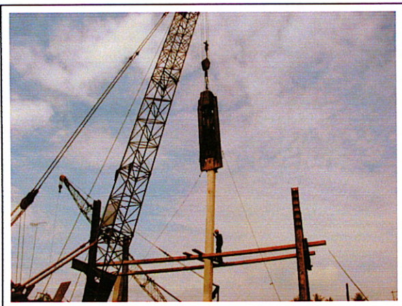
写真1 : くい打ち工事
