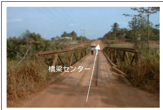
写真-15 (48)DAKIA (BINH PHUOC 省) 施設建設型
