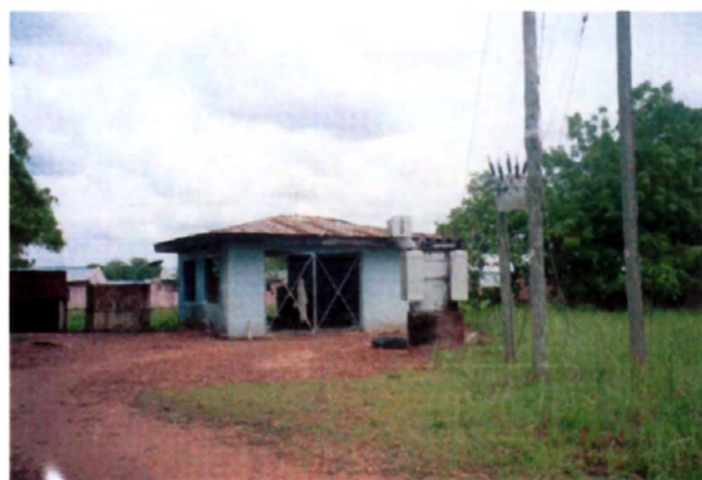
ケアナ町 既設発電所及び変電所建設用地
