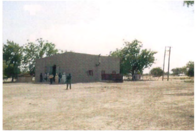
ダマサク町既設発電所及び変電所建設用地
