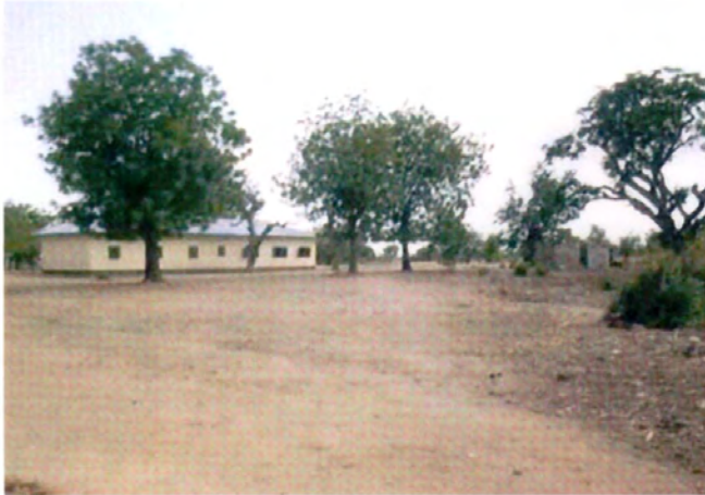
カッシングギ変電所建設用地
