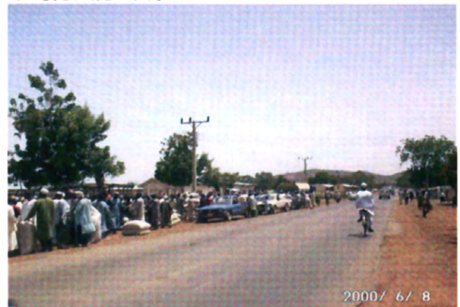
既設 33kV 送電線
