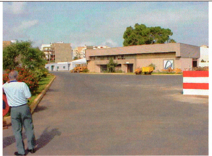
カサブランカのDRCR直轄の中央整備工場(Parc Central)の構内;調達計画による到着機材の再組立・調整・引き渡し場所となる予定
