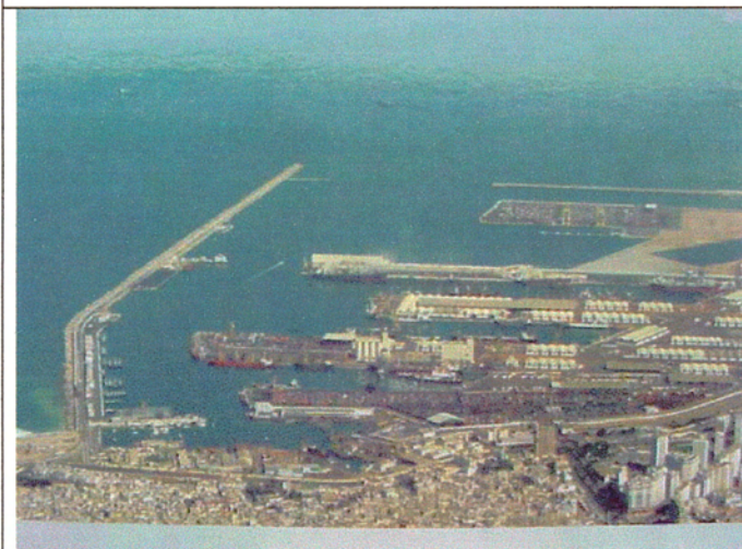
カサブランカ港;調達機材の荷揚げ予定港
