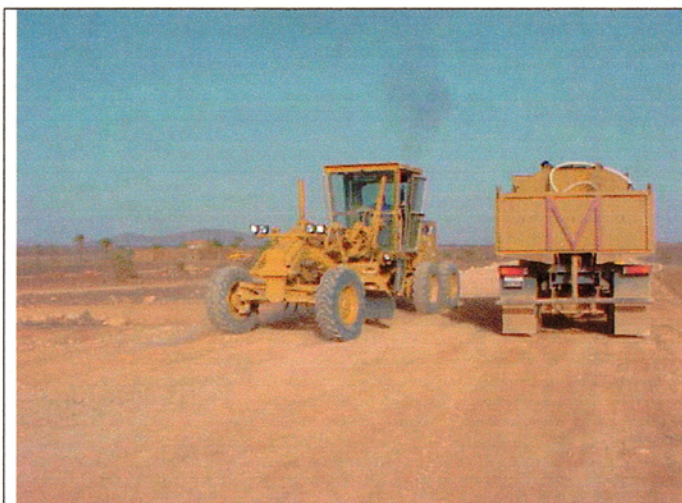
Ouarzazate 県内の村落道路；SLM の機材で整備中
