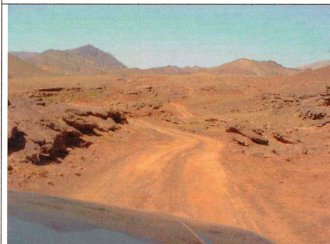
Ouarzazate 県内の村落道路；整備計画対象道路、岩盤地帯
