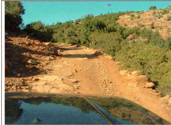
Azilal 県内の村落道路；整備計画対象道路、岩盤が多く難工事が予測される、
