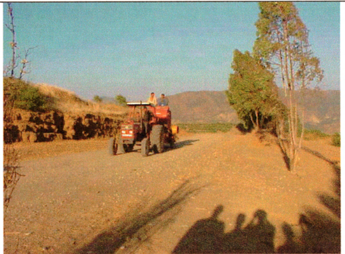
Taounate 県内の村落道路；整備済み、一般車両やトラクターもスムーズに走行している
