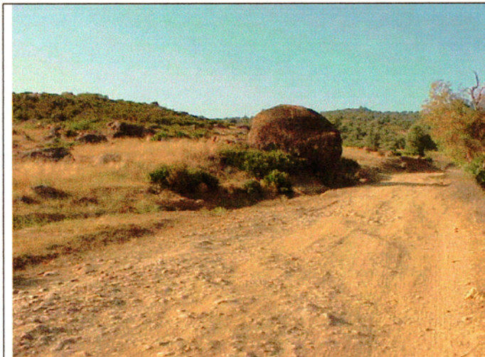
Taounate 県内の村落道路；整備計画対象道路、大きな岩がごろごろしており、発破による破碎が必要
