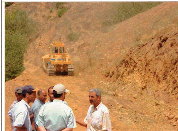
Taounate 県内の村落道路；SLM-中北部(Fes)の機材で整備中、25tクラスのブルドーザーではややきつい、大型ブルドーザーの導入を要望している
