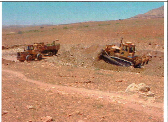
Marrakech 県内で砂利舗装用の川砂利（ワディ）を採取するブルドーザ、ホイールローダ、ダンプトラック
