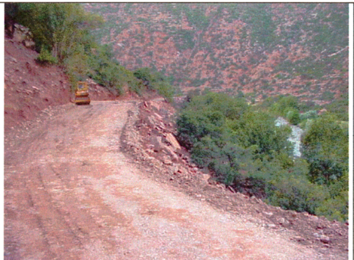
Marrakech 県内村落道路の整備直後の状況；道路幅を約8mに拡幅
