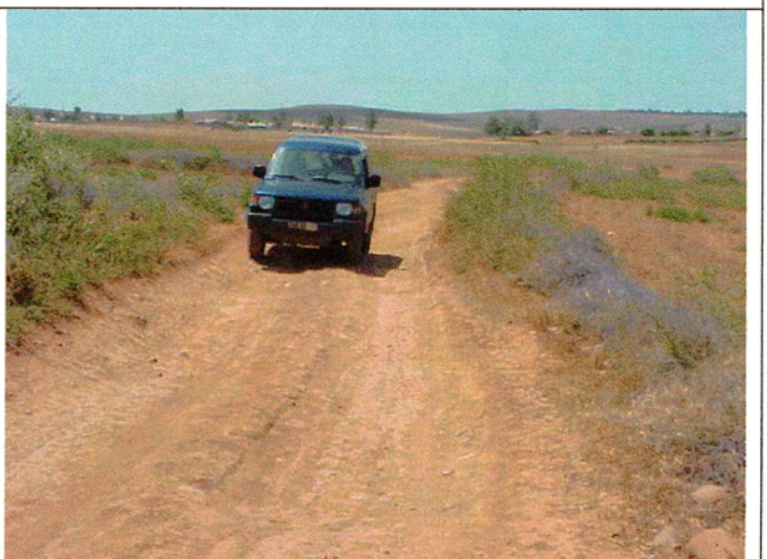
SidiKacem 県内の村落道路；整備計画対象道路、降雨によるぬかるみで通行困難となる、整備には盛土が必要
