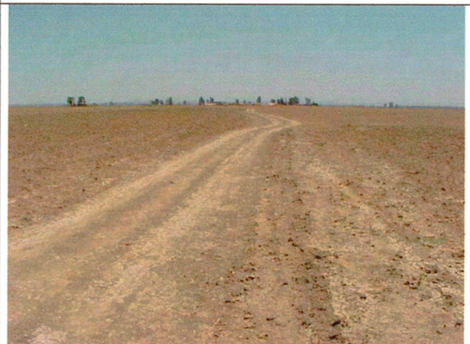
SidiKacem 県内の村落道路；整備計画対象道路、整備には盛土（0.5m以上）が必要
