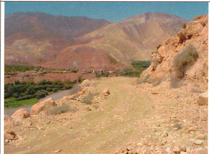
Marrakech 県内の村落道路；整備計画対象道路、拡幅が必要
