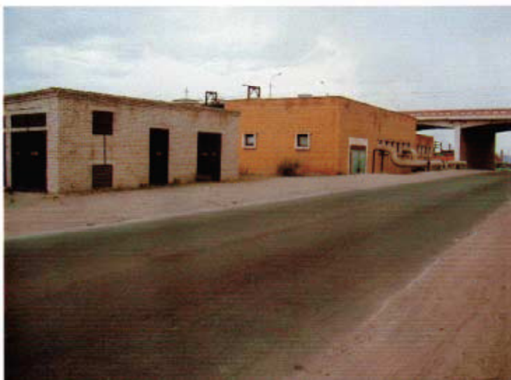
12) 平和橋東側 南側に給湯ポンプ施設と電気分配 施設が立ち並ぶ。
