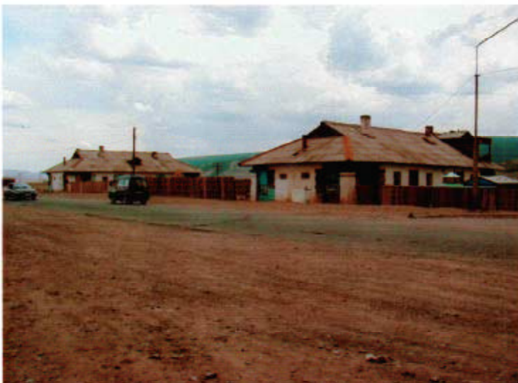
15) 移転家屋 ドッド セルベ橋と新中央市場の間、南側にある移転対象家屋 2 軒
