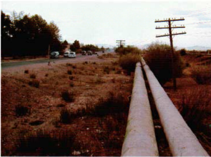
13) ナラヤンダル公園前 北側は、ナラヤンダル公園が隣接。 南側は、給湯パイプが並行しているものの、家屋等はなく、盛土も盛こぼしとなっている。
