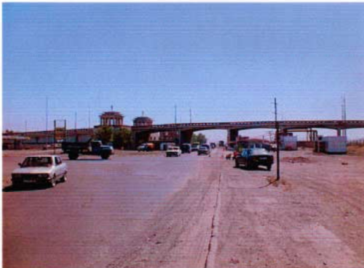
11) 平和橋西側 歩道が両側に設置されている。
