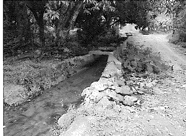
上：水路橋 水路橋本体はほぼ建設時の状況をとどめ漏水もほとんどみられないが、開水路取付トランジション部の破損個所の補修が必要である。
