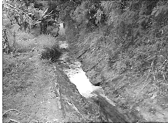
上：急流工（幹線水路中流部） 水路側壁・底版に破損がみられる。
