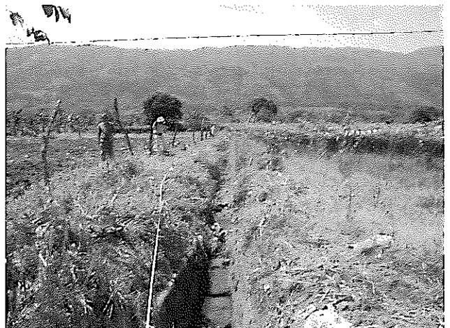
上：二次用水路 側壁煉石積コンクリートの老朽化により、下流部ではほとんど原型をとどめていない。
