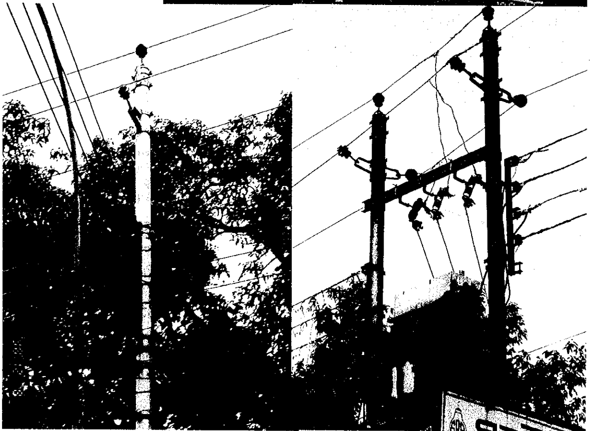
ダッカ市内の配電設備
