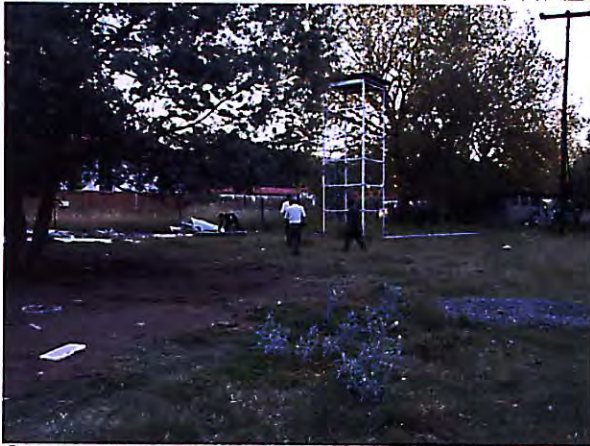
③サイト西側にある電柱および高架水槽。共に「レ」国側負担により移設される。高架水槽へ地下水を引き込み、トイレ等の2次上水道として利用する計画がある。
