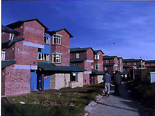
新学生寮の建物群。USAIDの援助により2000年3月に竣工したばかりである。遠目には美しいが、特に内部における細部の納まり等はかなり粗雑で、施工精度は良くない。
