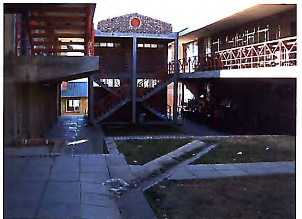
世銀の援助により一部増築が行われた教室棟。新管理棟同様、現地仕様により建設費を押さえている。雨樋はなく、雨水排水はキャンパス内の他の建物と同様自然浸透式となっている。
