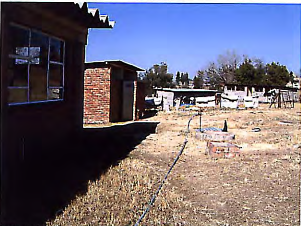
⑤実験棟脇に天然ガス発生装置を設け、調理実習室まで引き込んでいる。現在は破損して使用できないため、本件実施に際し取り壊すことで先方に了解を得ている。
