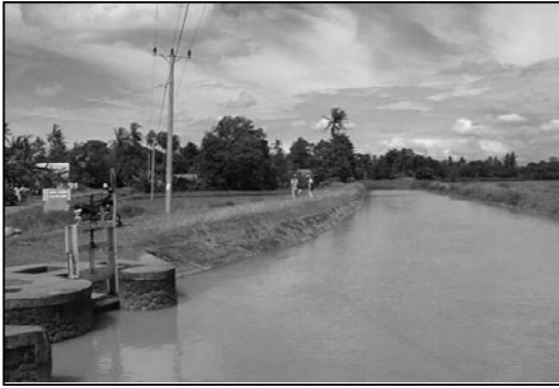
水源、浄水場及び配水池予定地
