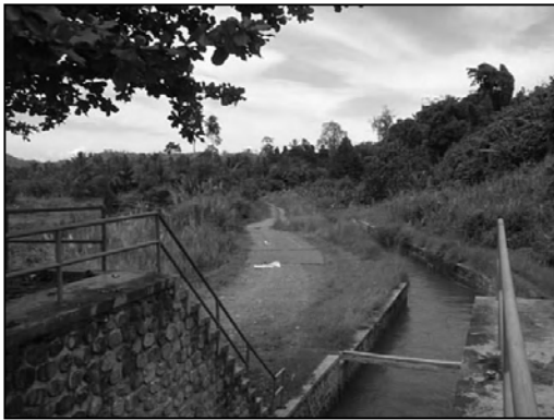
水源及び浄水場予定地
