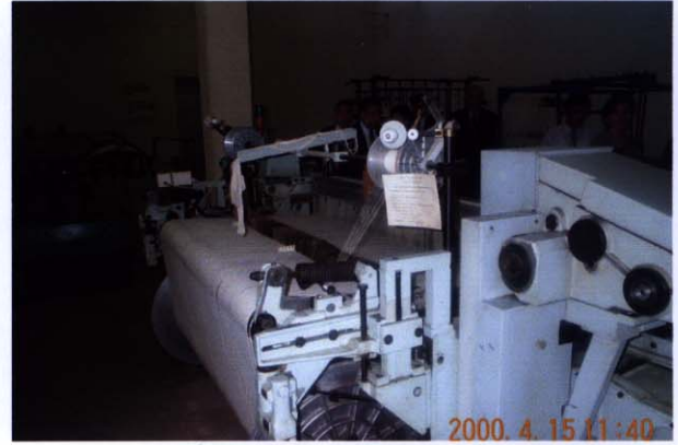
TITLI既存機材確認2
