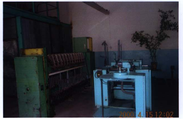
TITLI既存機材確認12
