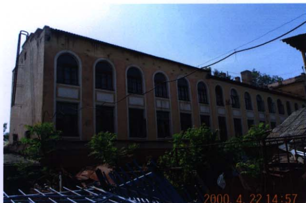
タシケント繊維軽工業大学 2号館後部(繊維製品試験室)
