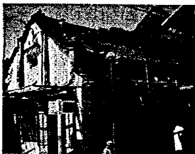
写真-3 屋根替え工事
