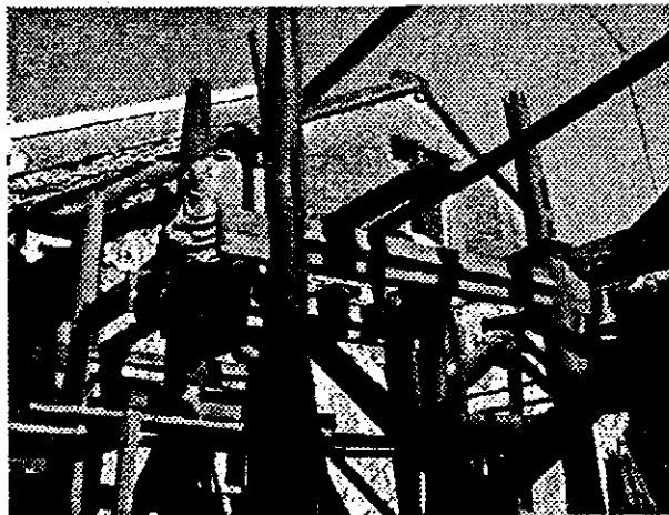
写真-5 架構の組み立て
