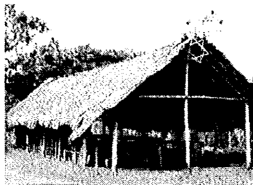
寺の敷地に建設された塾
