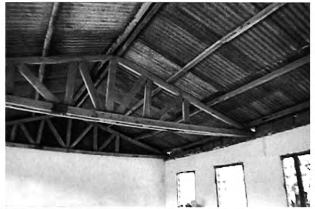
12. 構造的な屋根(Kurasini P.S.)
