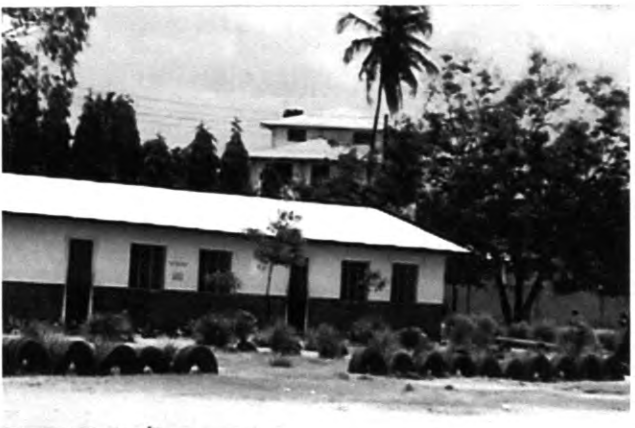
7. 住民資金のみで建設(Kurasini P.S.)
