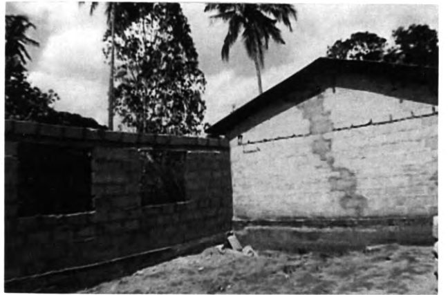
30. 増設中、臥梁がある(Kinyerezi P.S.)
