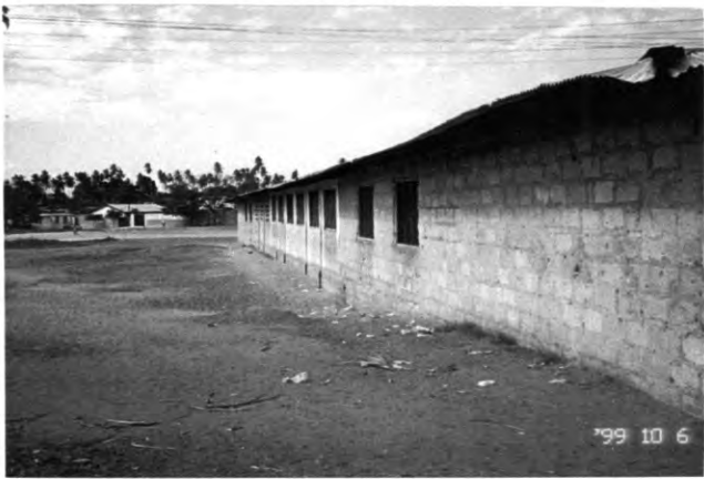
3. 住民建設、数次に亘って建設されている(Mbagala P.S.)
