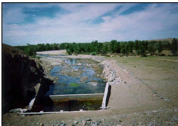
写真 I. 10. 7-2 バルントゥルーン水力地点
