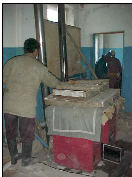
写真 I.7.9-3 個別集中暖房システム（自然循環方式）のボイラー
