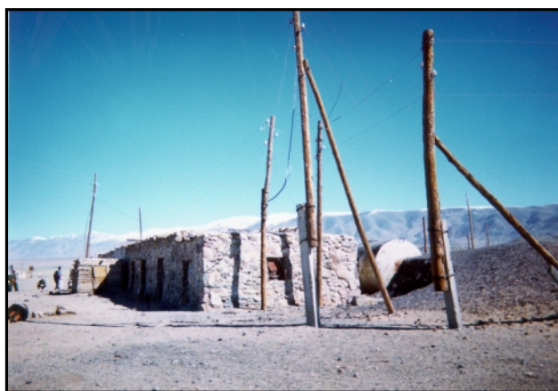
写真 I.7.5-1 バヤンウルギー県トルボ・ソム・センターの配電線
