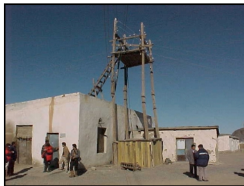
写真 I.7.4-1 ホブト県マンハン発電所建屋
