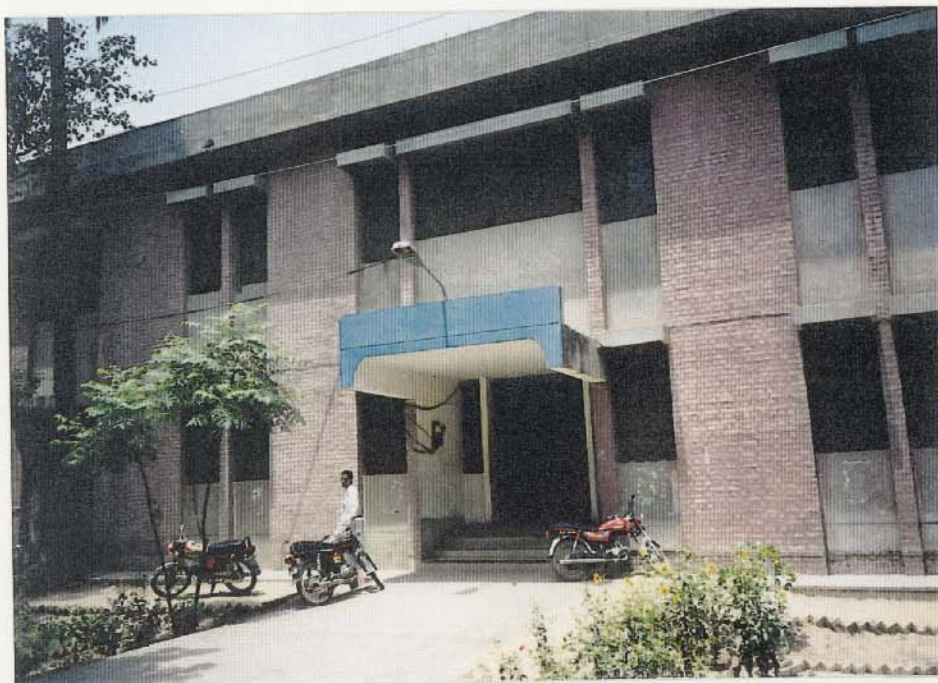
【GUJRANWALA 県保健事務所】 建物内に県ワクチン倉庫が付属
