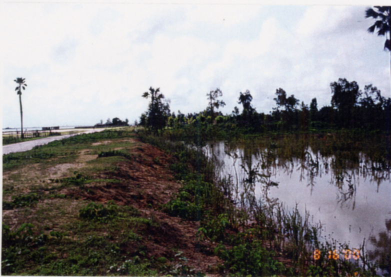
小規模堰防により左側の川からの塩水の侵入を防ぎ右側部分を淡水化し、水田を造成する (Fimela 近郊で)。
