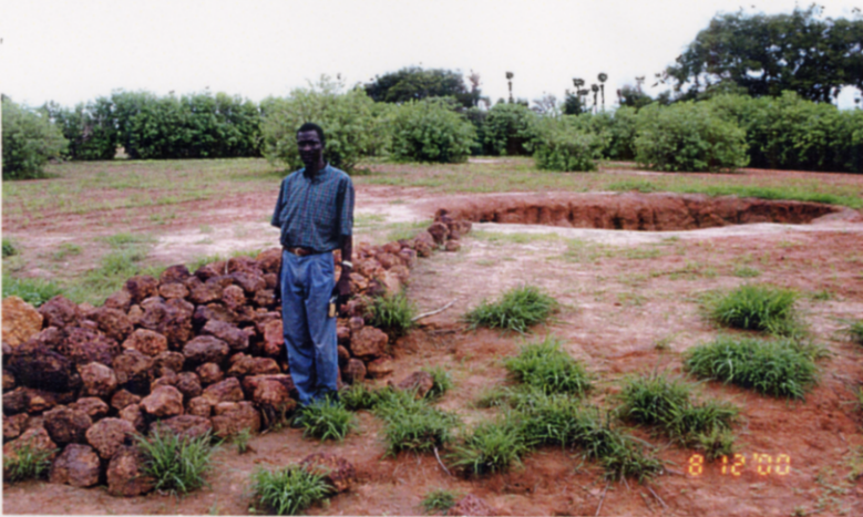
荒廃した小沢での石積みによる エロージョン・コントロール。 (Thies 近郊で実施された FOA の PREVINOBA プロジェクト)
