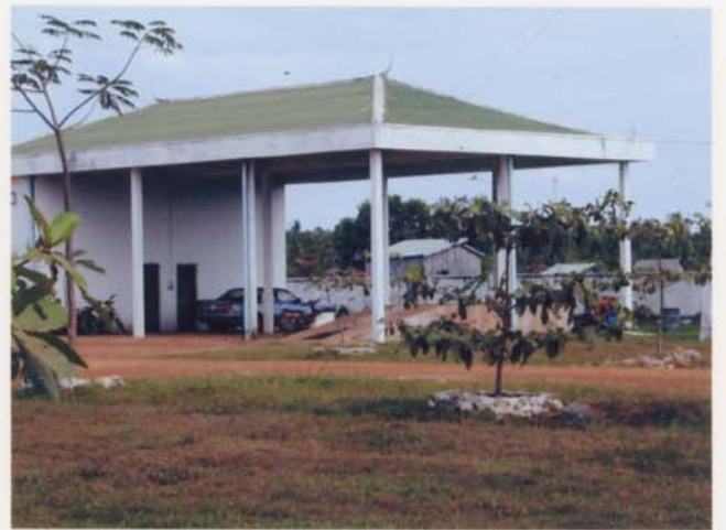
コンボンチュナン訓練センター敷地内にある車輛整備場
