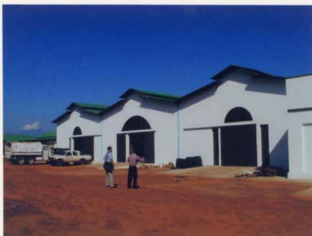
コンボンチュナンに建設された倉庫外観
