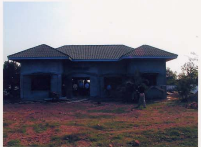
バットンバン実行本部予定地で建設中の建物
