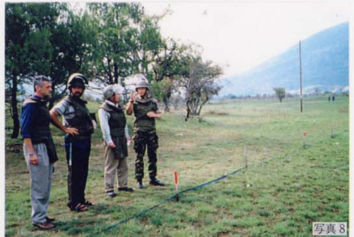
写真8 モスタルでの地雷除去現場：現在も作業中である。
