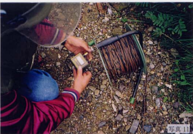
写真11 コードリールを起爆ヒューズに取り付け遠隔操作する。
