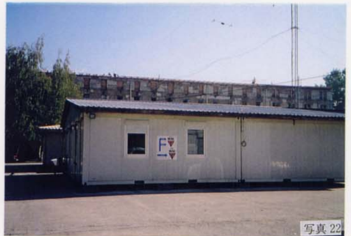
写真 22 FMAC 及び BHMIC の事務所：コンテナを改造している。
