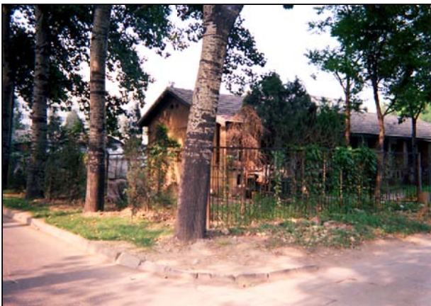
センター予定地 建物建設
