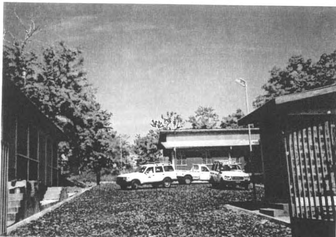
EMA 標準ラジオ送信所建物敷地入口
