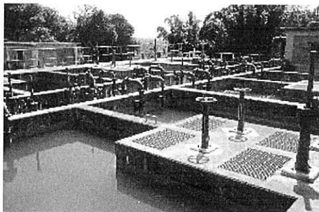
バンスバリ浄水場生物ろ過施設（地下水処理用）
