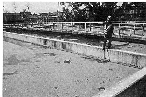
バンスバリ浄水場凝集沈殿池（生物ろ過施設が運転休止中により、窒素が沈殿池に流入、藻類が大量発生した）
