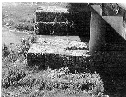
マノハラ川下流河岸及び橋梁防護施設
