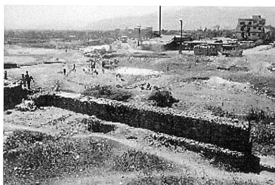
マノハラ川下流河岸及び橋梁防護施設
