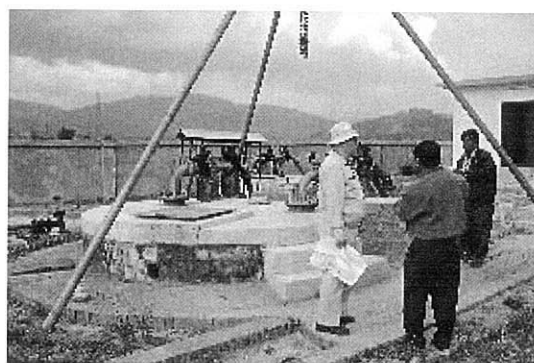
浅井戸と送水ポンプ
