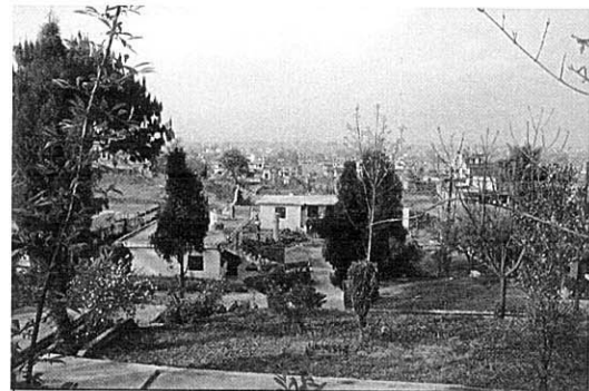
シャイブー既存配水池方向から市内を望む
