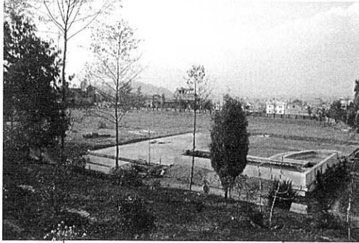
既存シャイブー配水池
