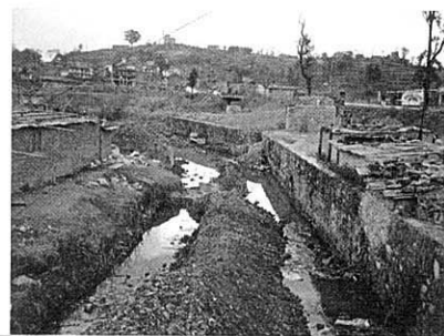
取水予定地上流、開発が進む
