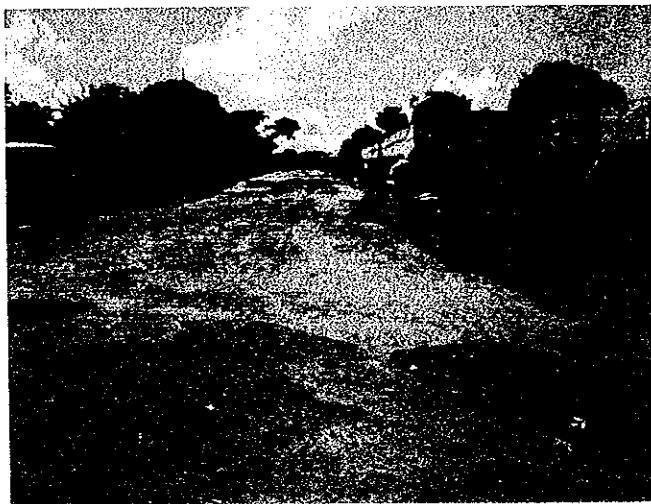
舗装破損状況その3（コレクター道路）
