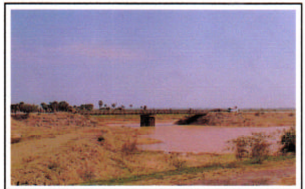
26号橋 現橋位置から上流側に仮設橋(幅員4m)が設置され交通供用中の状況
